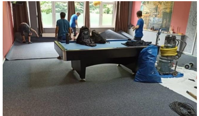
Der Teppichboden wird verlegt.
